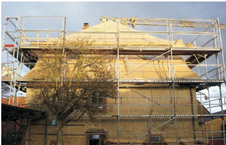
Isolation entre chevrons avec Hofatex® TopTherm
